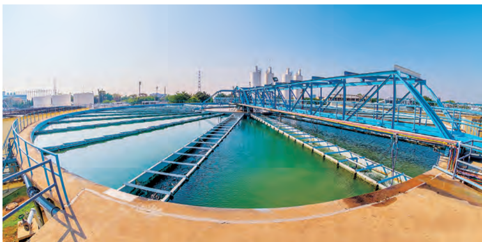
Очистные сооружения, Московская область
